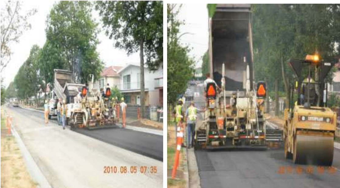
Fig 3: Laydown, NO FUMES
